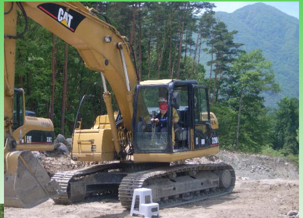
作業に使う建設機械に触れてみました
