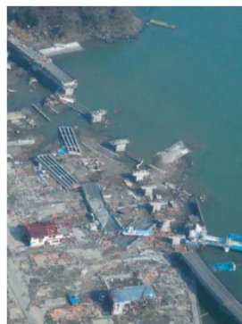
宮城県 南三陸町 国道45号 歌津大橋 L=304m
