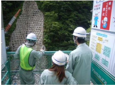
中田切第四砂防堰堤工事現場見学
