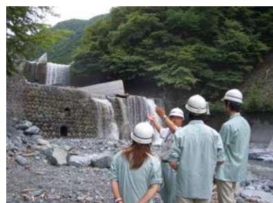
釜沢砂防堰堤補修工事現場見学
