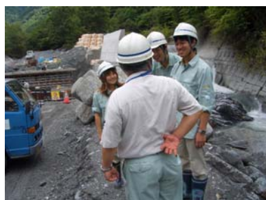
三正坊護岸補修工事現場見学
