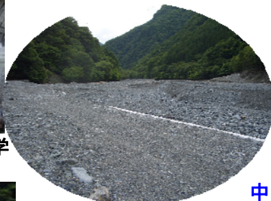
釜沢砂防堰堤上流の堆砂状況
