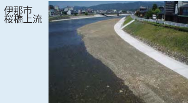
工事直後(平成21年5月)
