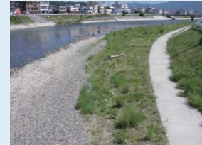
工事後(平成22年8月)
