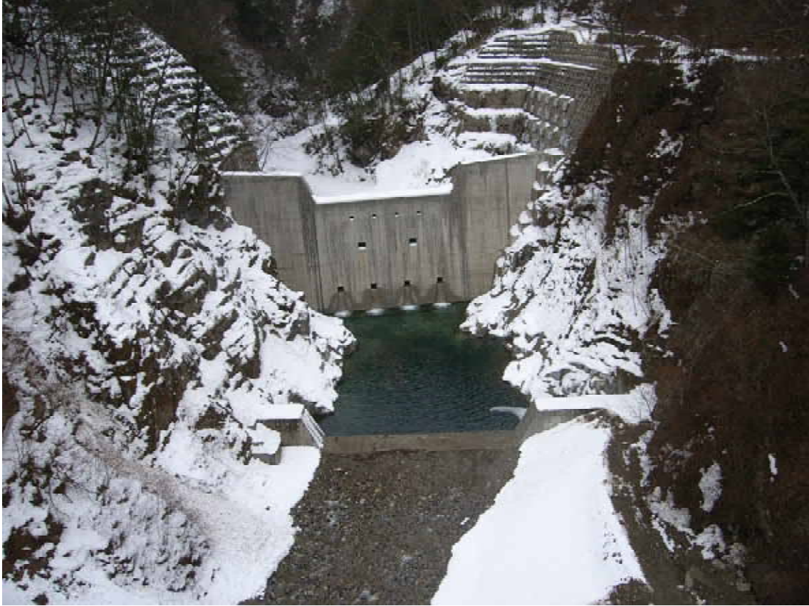
写真：完成した中田切第4砂防堰堤
