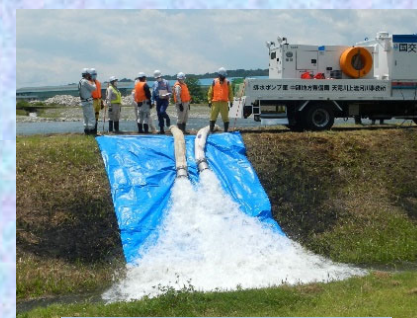
排水ポンプ車排水状況
