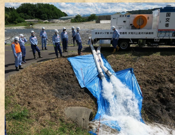
排水ポンプ車排水状況
