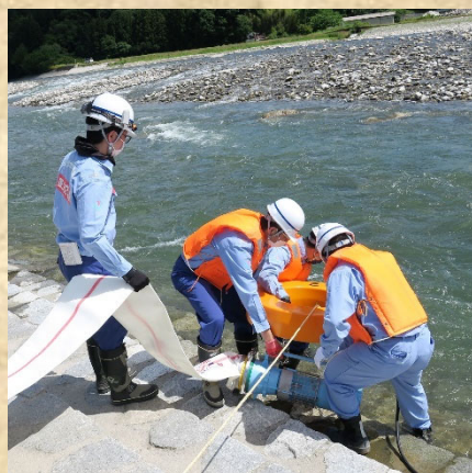
排水ポンプを設置
