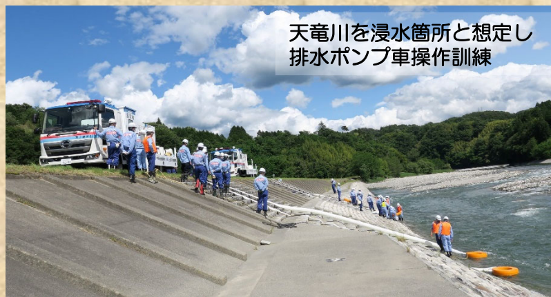
排水ポンプ車の設置
