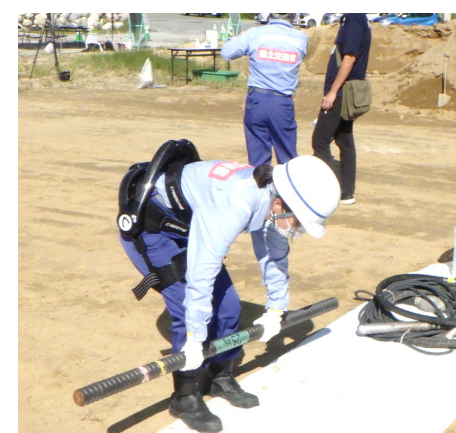
鉄筋の運搬
