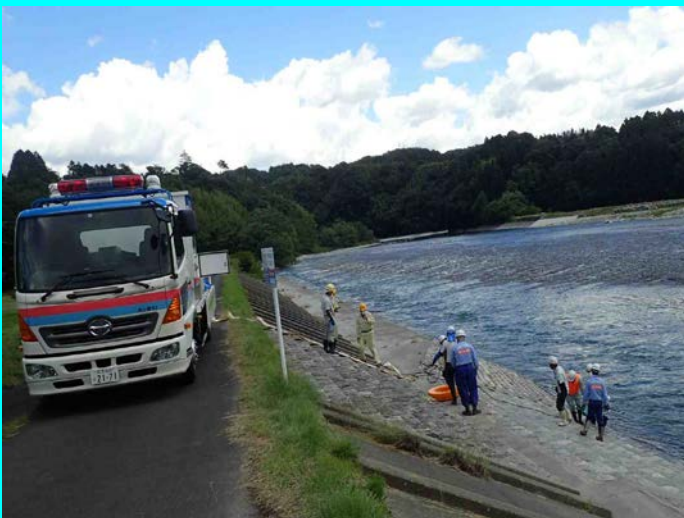
排水ポンプ車(新型)排水状況
