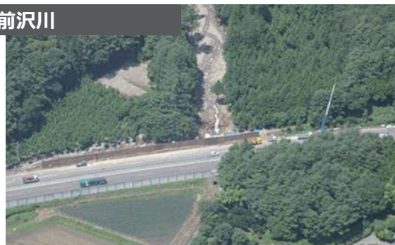
防護壁の設置作業中(中央道)
