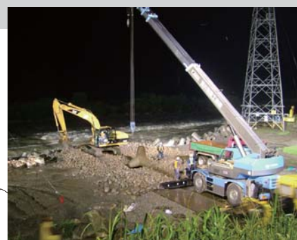
ブロック据付状況
