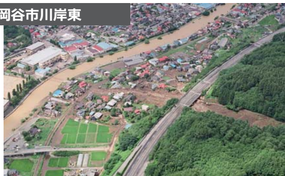
中央道をくぐり住宅地を襲った土石流
