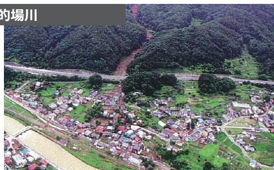
住宅地に土石流
