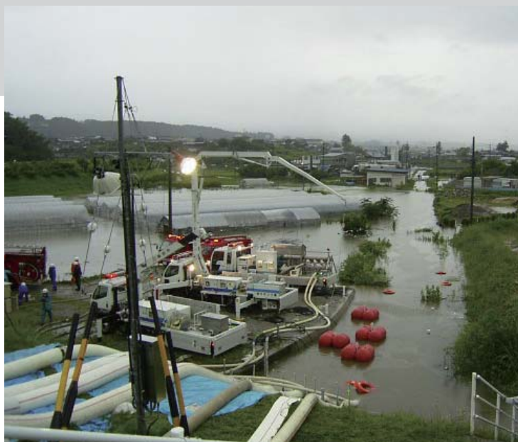
飯田市 松尾地区（排水ポンプ車2台）
