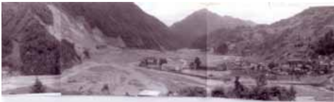
大西山崩壊状況
