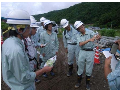
・藤沢川砂防林工事
