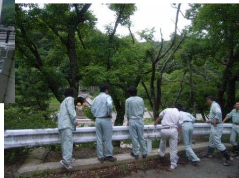
美和ダムにて、排砂バイパストンネルの 状況を見学し、土砂についての問題を 考えました
