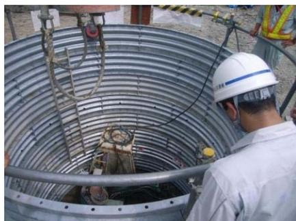
・入谷えん堤補修工事(集水井掘削現場)
