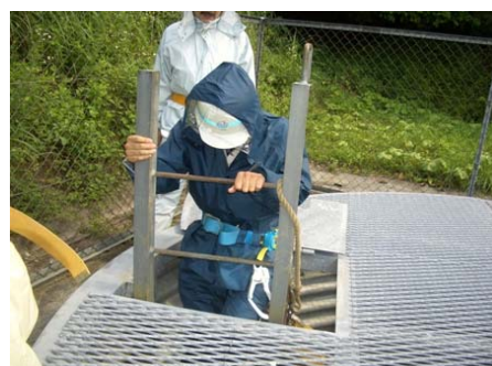
集水井の中地下水が流れひんやりしています
