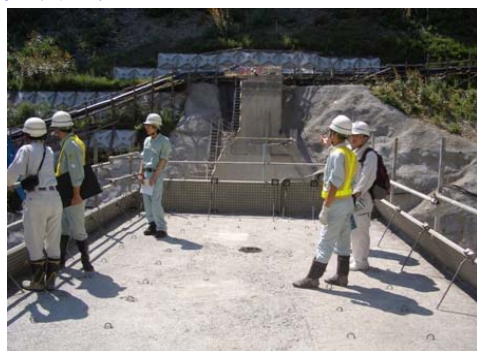
・伊ノ木沢砂防えん堤工事現場
