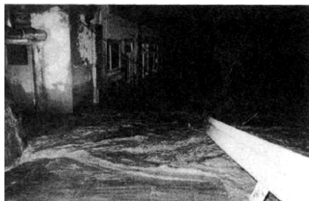
日市川路天竜峡 床上浸水（天竜峡ホテル）
