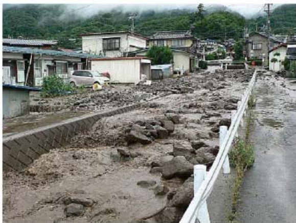
土石流で閉塞した河道
