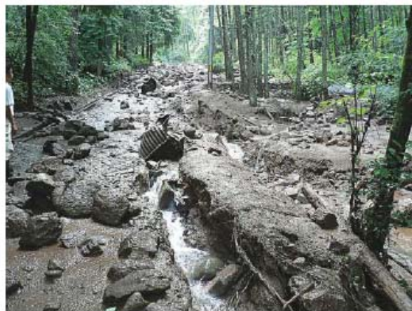
土石流が道路に氾濫
