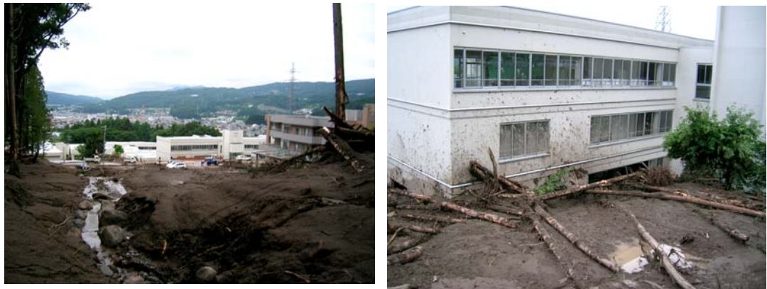
図 36 土石流被害にあった上の原小学校
