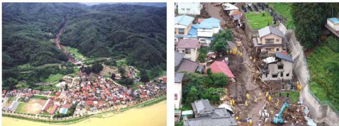
住宅地を襲った土石流
