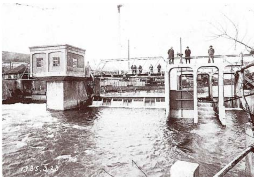
図 12 完成した西天竜ローリングダム
