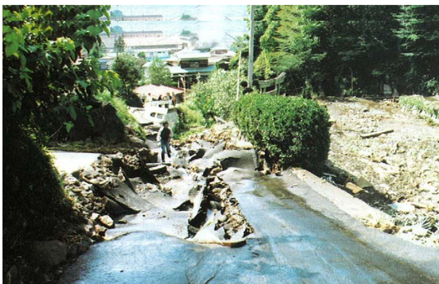
図 25 唐沢川の氾濫状況
