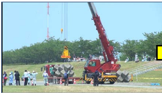
玉掛→吊り上げ
