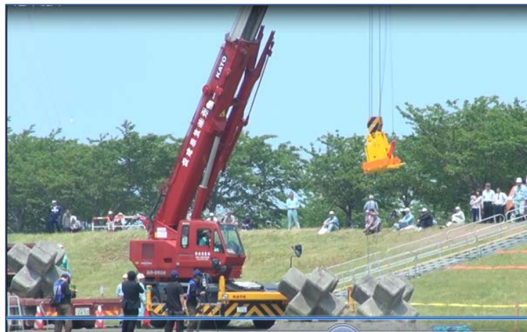
ブロック切り離し時に反動が発生
