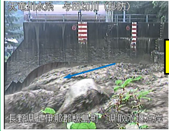
土石流発生時 (R4.9.1)
