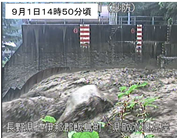
【土石流の流出状況】
