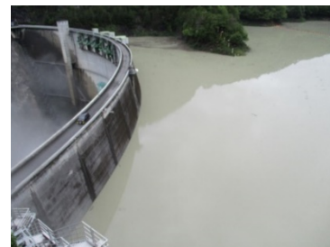
洪水後小渋ダム貯水池状況 (8月16日8時)
