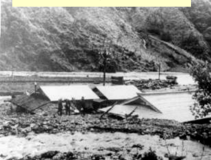
S36災 伊那市長谷の被災状況
