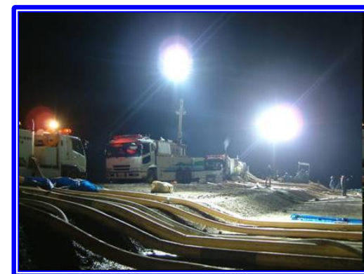
東日本大震災に出動し支援活動を実施 (照明車及び排水ポンプ車による排水活動)
