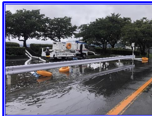
令和3年8月豪雨 排水支援 (諏訪市)
