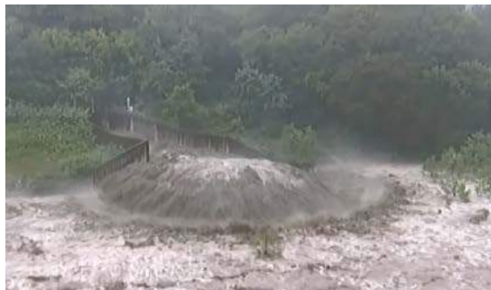
土砂バイパストンネル吐口（10月12日 14時頃）
