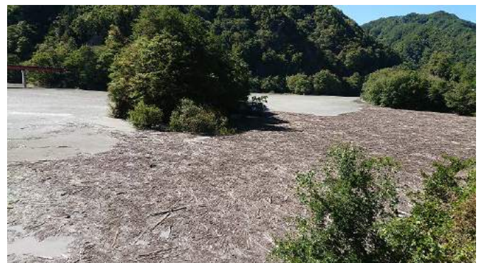
小渋ダム流木補足状況写真
