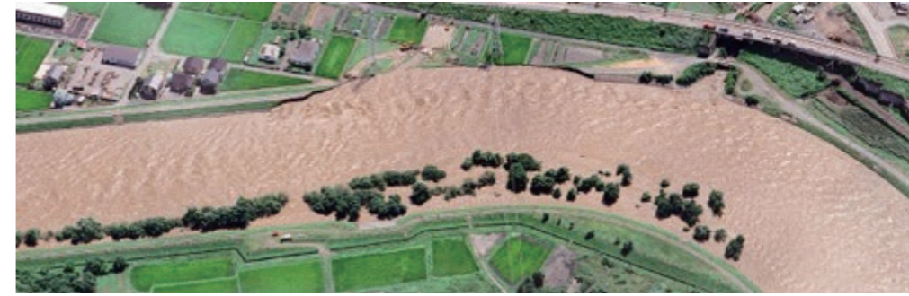
写真 天竜川本川(箕輪町松島地区)の堤防決壊箇所
