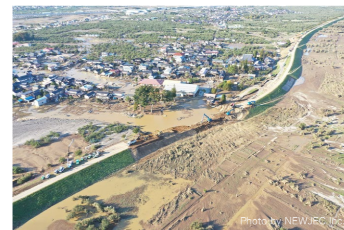
写真 令和元年台風19号の豪雨による千曲川の堤防決壊
