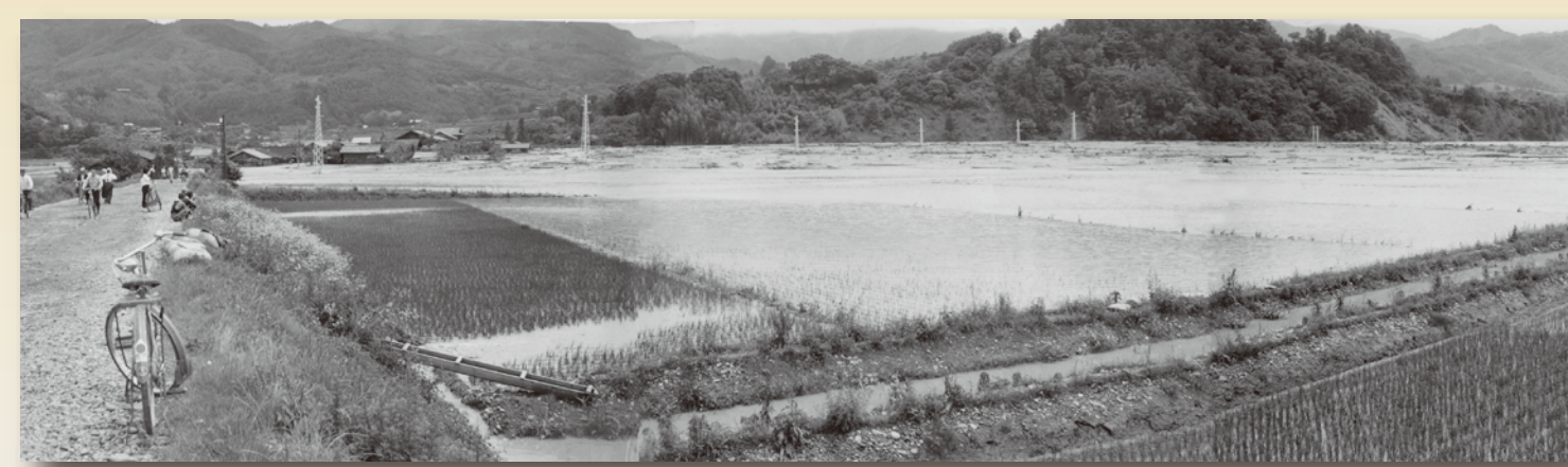
新宮川の合流点付近の氾濫(駒ヶ根市中沢)
