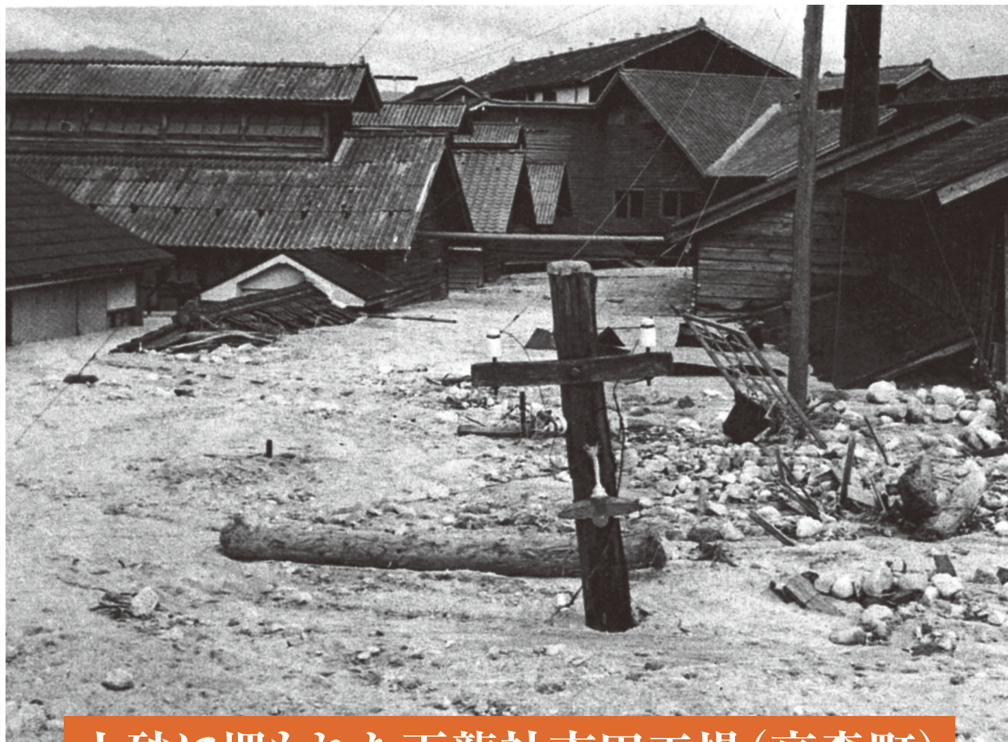
土砂に埋もれた天龍社市田工場(高森町)
