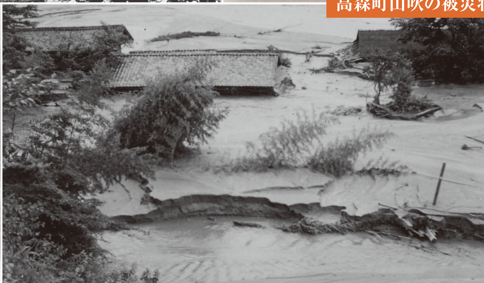
高森町山吹の被災状況
