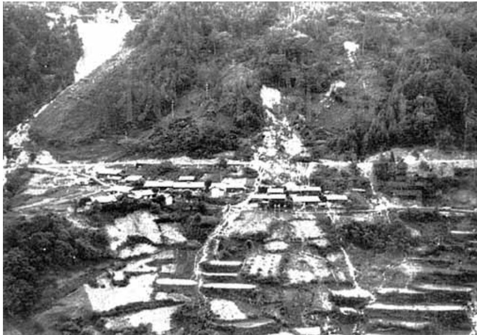
斜面が崩壊した桃ノ木集落
