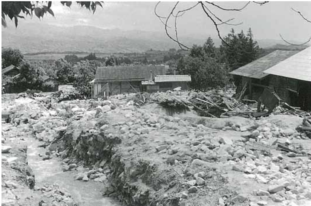
王竜寺川と押洞の合流点の被災状況
