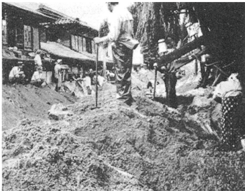
氾濫後の東中央通りの罹災者 野底川の氾濫により一階の屋根を埋めた土砂を排除する罹災者
