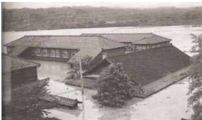
「水つき学校」と言われたとはいえ、校舎2階まで浸水した川路小・中学校。
