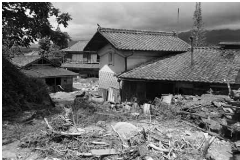
割出川の氾濫で流木や土砂が押し寄せた民家
