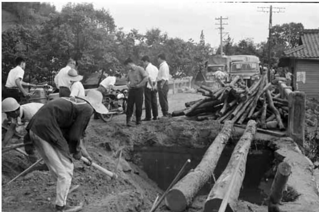
虻川橋手前の、河岸侵食による陥没
