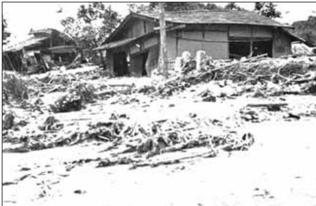
町道1-2号線(竜西線)のすぐ下で土砂に埋まった家屋
