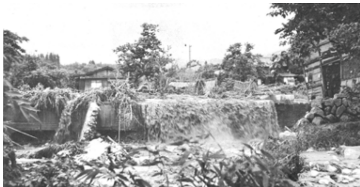
竜西一貫水路の水路橋が流木でせがり氾濫して住宅を押し流した。写真右側の石積が川の護岸、現在はサイフォンで川の下を通っている。
