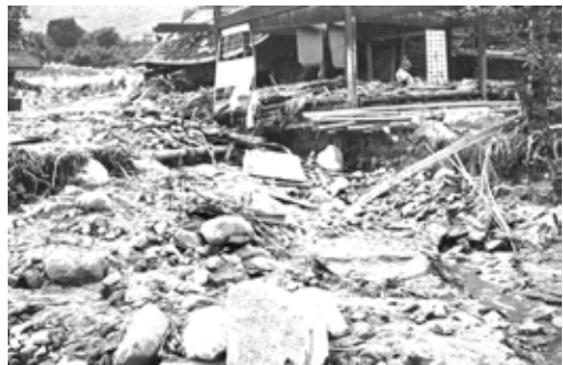
半壊した住宅。また、飯田線の下流 200m 付近隣接していた住宅は全壊した。
