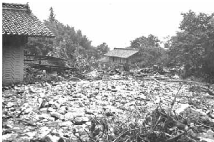
間ヶ沢川の氾濫で埋没した町道 1-2 号線（竜西線）の上流付近
