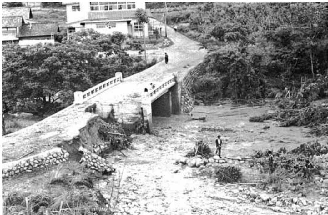
大島川の氾濫で欠潰した町道中央線と城岸橋。前方建物は市田農協
