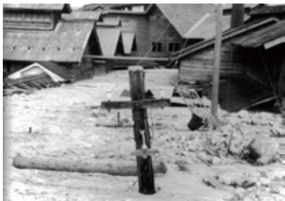
堤防決壊により被害を受けた天竜社市田工場
