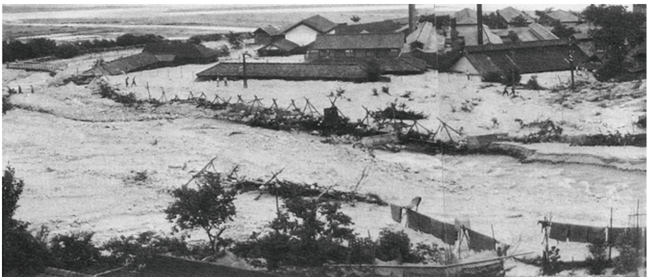
大島川の氾濫で一面の砂礫の河原と化した出砂原。 その後同じ位置の復旧状況として、昭和39年に鉄道は飯田線が復旧し、昭和56年頃には国道、バイパスが開通し宅地化がすすんでいる。
