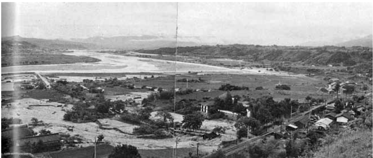
大沢川と唐沢川の氾濫で流失、埋没した山吹駅東方の住宅と水田地帯
