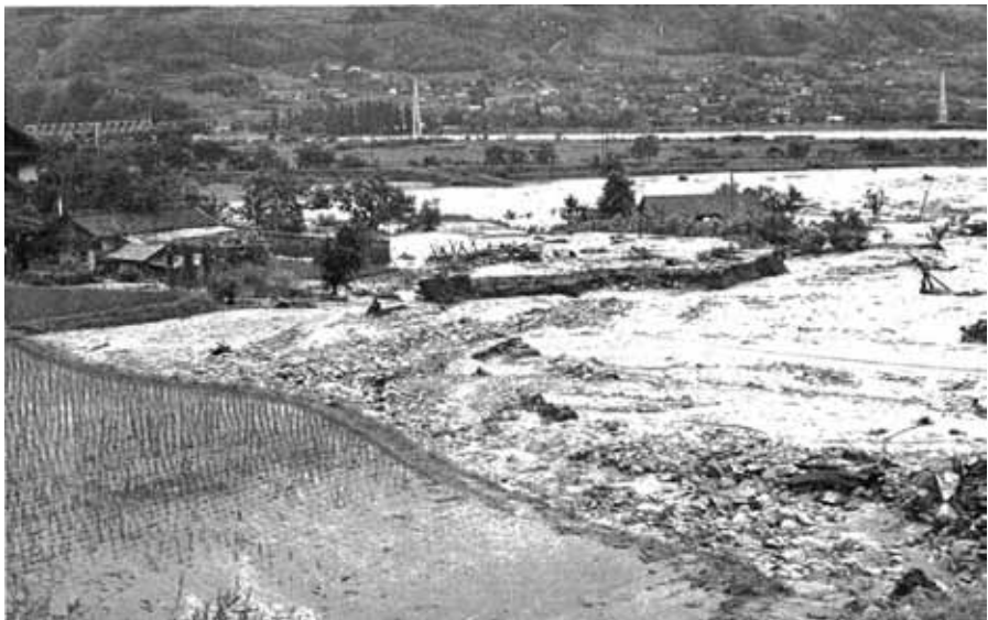
大沢川の氾濫状況。手前が大沢川、奥の白い線が天竜川。
