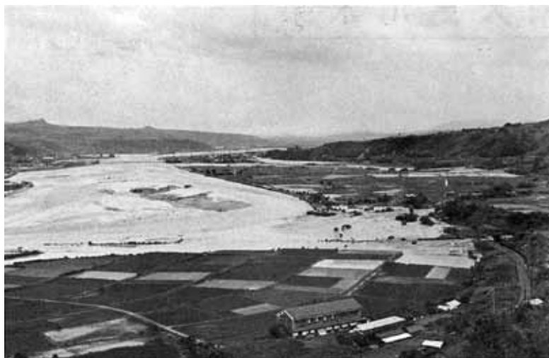
天竜川駒場河原の被災状況。 山吹駅上空から南方を見る。手前の建物は山吹農協稚蚕飼育所。 天竜川の氾濫で流失した駒場河原と田沢川、寺沢川で流失埋没した下平駅付近がみえる。
