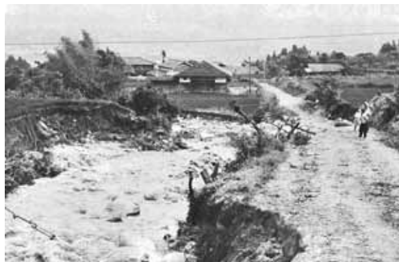
胡麻目川の剣道飯島飯田線(上県道)、新川橋下流付近の惨状
