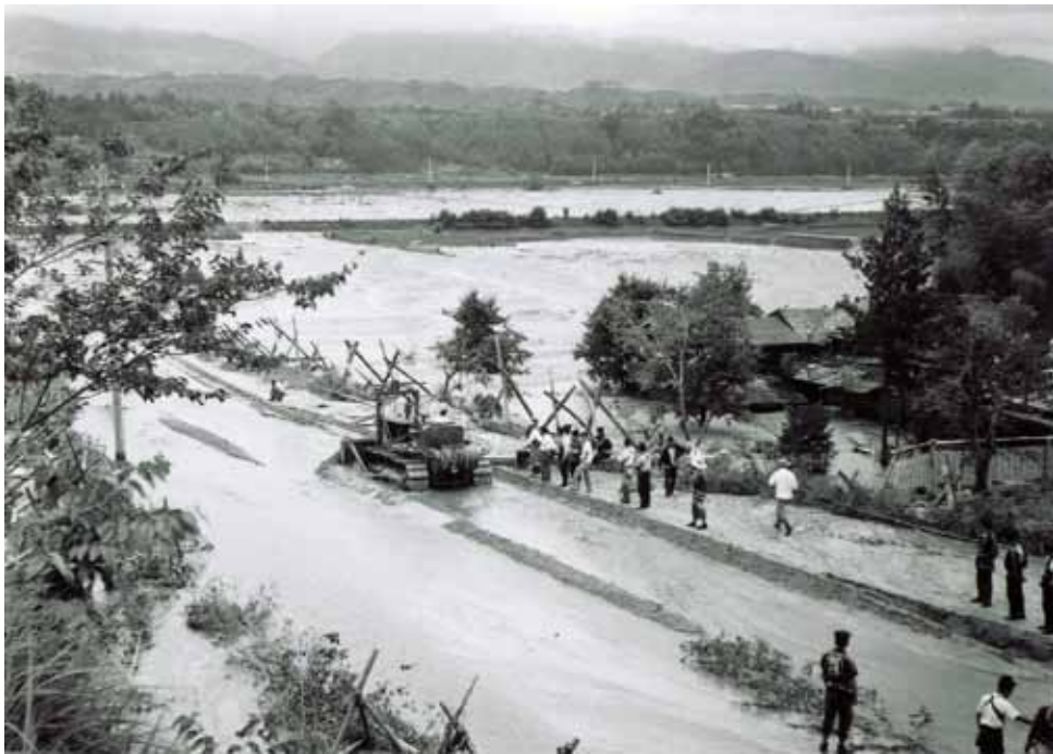
天竜川との合流点手前で6軒被災した場所の水防作業。上方は天竜川（右から左に流れている）。当時のブルドーザーは油圧装置がなく、排土板をワイヤーで上げ下げした。
