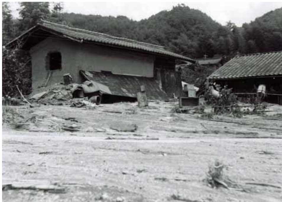
家が土砂で埋まり、土蔵の2階に入口を開け、はしごを架けて出入りする。
