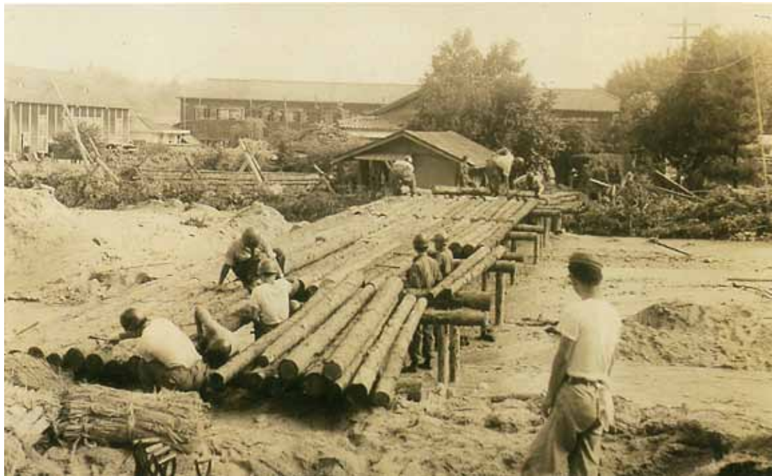
自衛隊による福沢川の仮設工事の様子。後方は松川中部小学校
