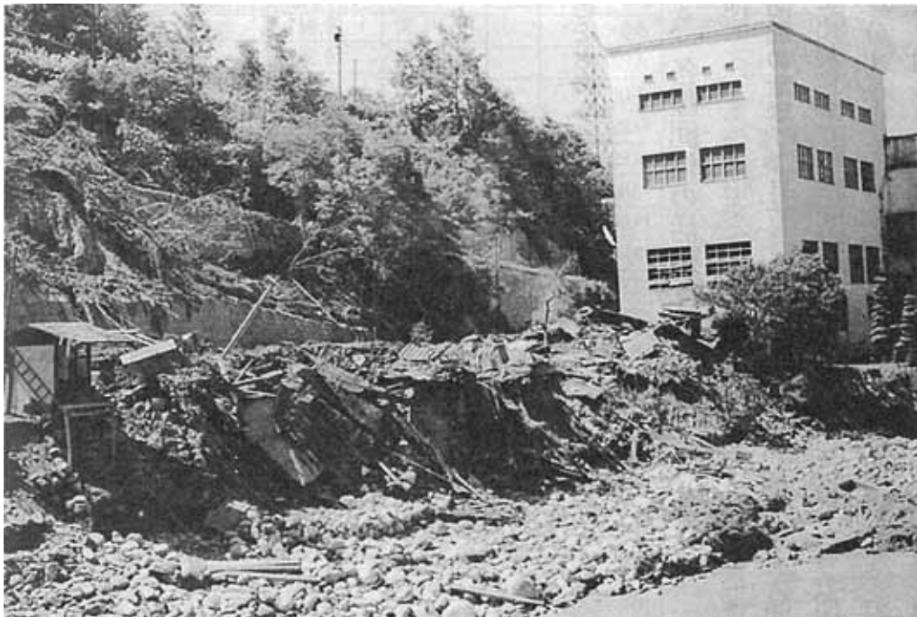
山崩れで押し流された家屋
