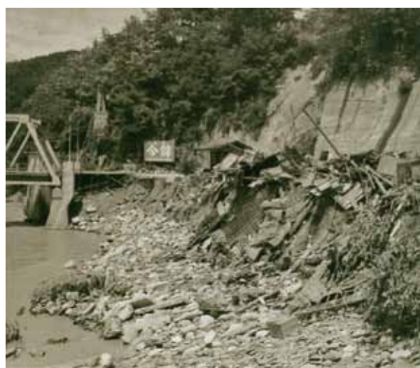
梅雨前線豪雨の三六災害で地滑りにより一瞬にして家屋を失った。
