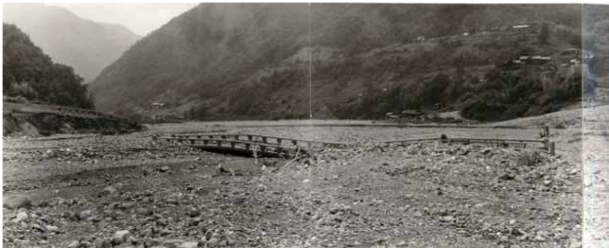
押し出された土砂により、埋まってしまった北川に架かる橋
