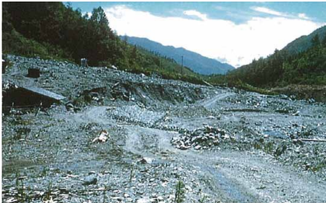
被災後の北川集落の中心部、味噌ゆるぎ橋付近
