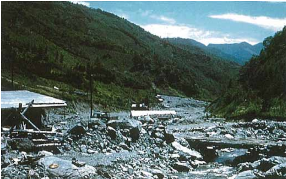
三六災害で被害を受けた北川集落の中心部、中央に北川分校が屋根だけ残っている。北川分校は土石流でいち早く破壊された。その後、支溪・大花沢からの土石流で鹿塩川の河床が上昇したため、川沿いの民家が土砂に埋没した。
