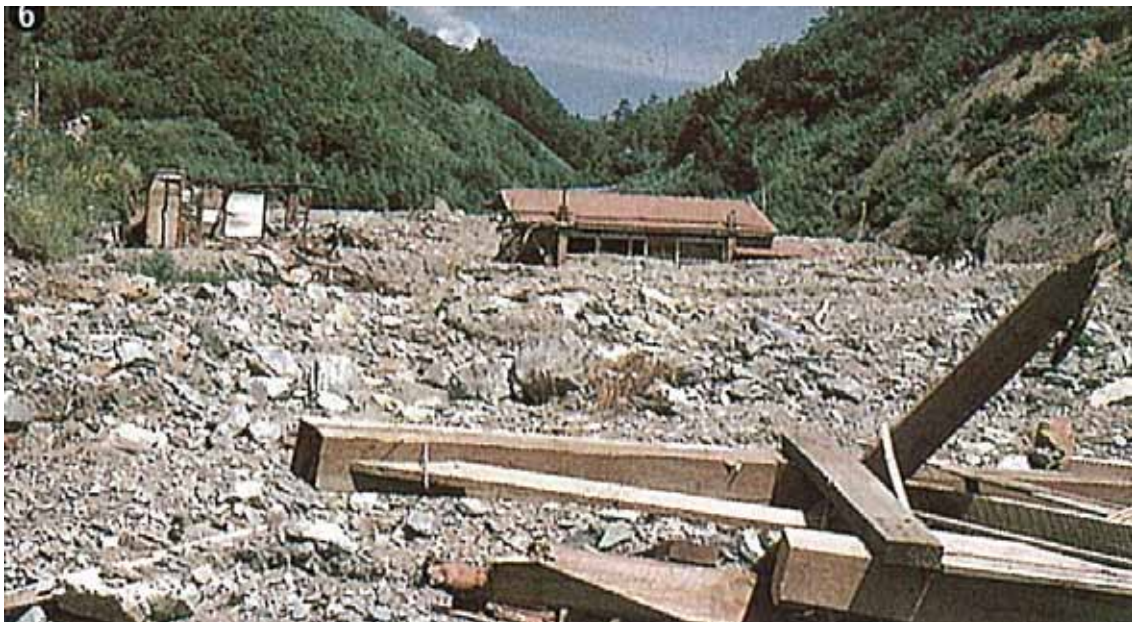
北川分校は土石流におそわれ、いち早く破壊されてしまいました。一方大花沢からの土石流で本流の河床が上昇し、川沿いの民家は土砂に埋没してしまいました。(土砂に埋まった北川分校を下流より望む)
